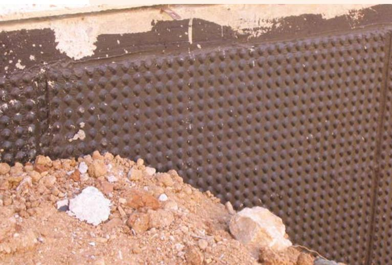
plastomerici ad alta resistenza in grado di conferire al manto impermeabile una corazzatura che lo protegga nelle applicazioni in fondazione a ridosso del terreno (sistema DRY-OUT) o all'interno dei vani interrati (sistema DRY-IN). ARMODILLO oltre a svolgere la funzione di impermeabilizzante corazzato è anche drenante. Quindi la sua funzione 2 in 1 permette, con un solo prodotto, di avere impermeabilità ad alta resistenza e drenaggio.
